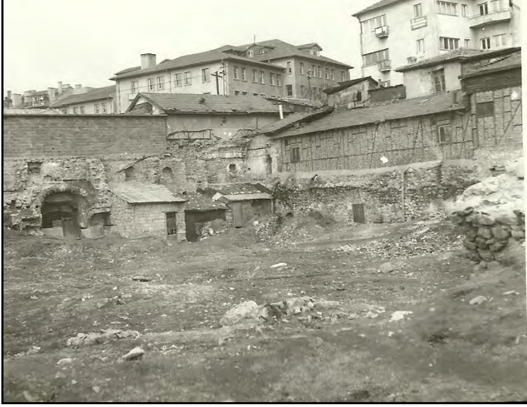
Fotoğraf 4: Sulu Han Kuzey Doğu Köşesi (Tamamıyla yıkılmış durumu) (1971) Kaynak: Vakıflar Genel Müdürlüğü Fotoğraf Arşivi
