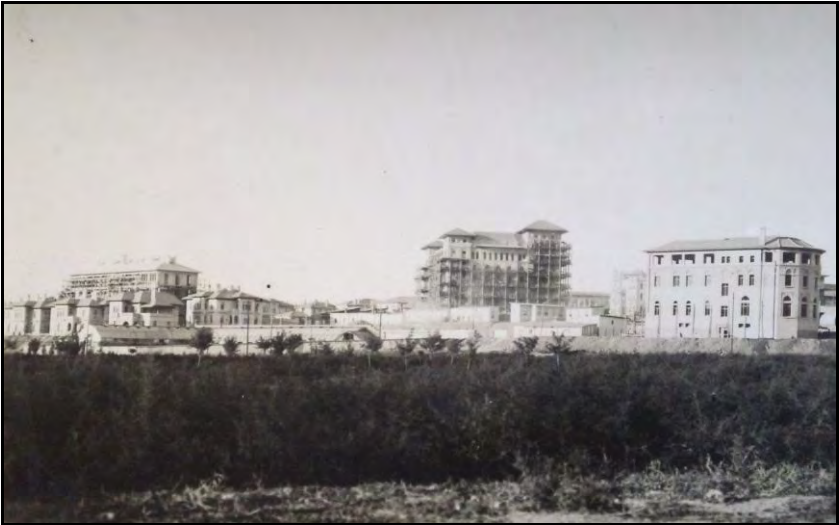
Osmanlı Bankası, Ziraat Bankası, Belvü Palas inşaatları sürüyor. Vakıf İşhanı temel seviyesinde (1928) Kaynak: Halûk İmga Koleksiyonu
